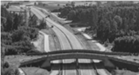
Przejście dla zwierząt nad drogą ekspresową S61
